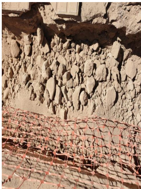
Relleno de canalizaciones y zanjas
