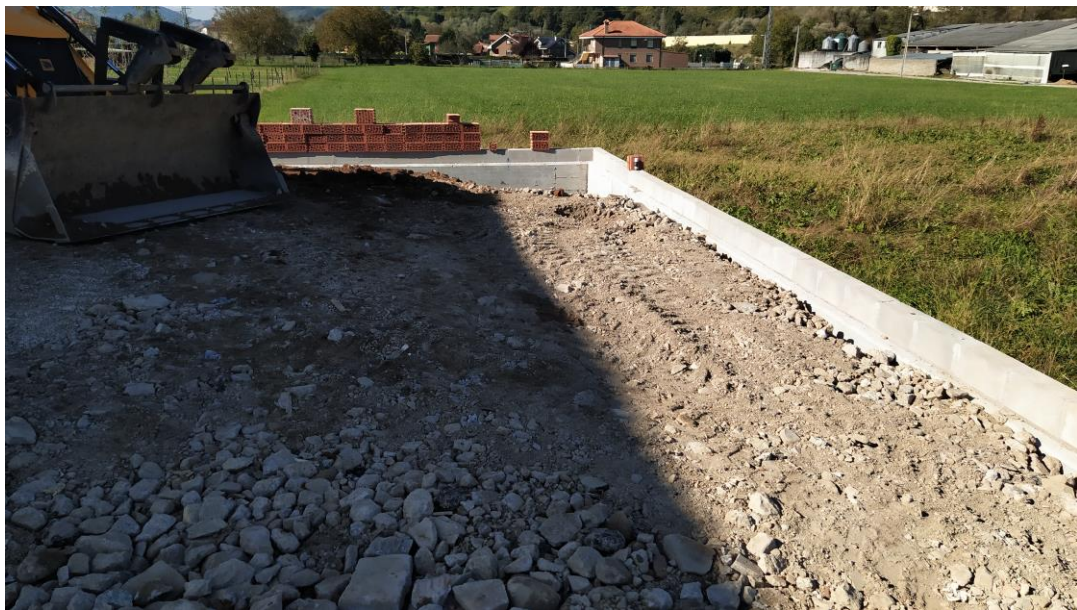
Árido reciclado de hormigón reciclado utilizado para subir cota de viviendas.
