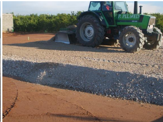
OBRA ADECUACION AVDA. HNOS BOU CASTELLON-RELLENO CANALIZACIONES
